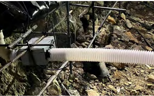
招商交科隧道地下水排放智能控制系统 Tunnel groundwater discharge intelligent control system of CMCT
